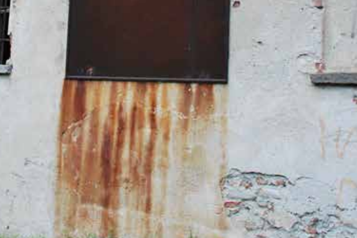
Dettaglio sul prospetto est, pannello in ferro
